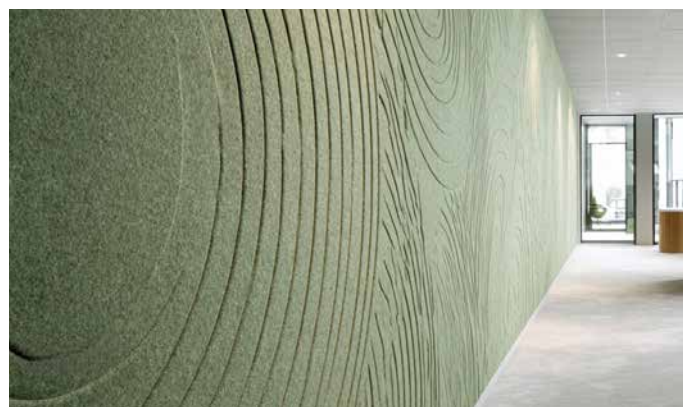
V-Fräsung an der Wand befestigt
