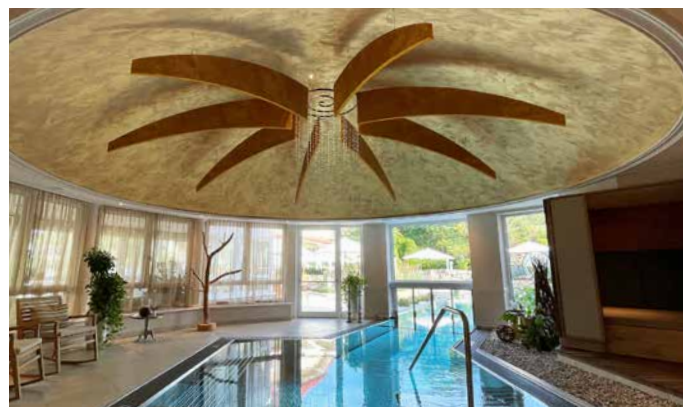
Akustikpaneele als Gestaltungselement im Poolbereich
